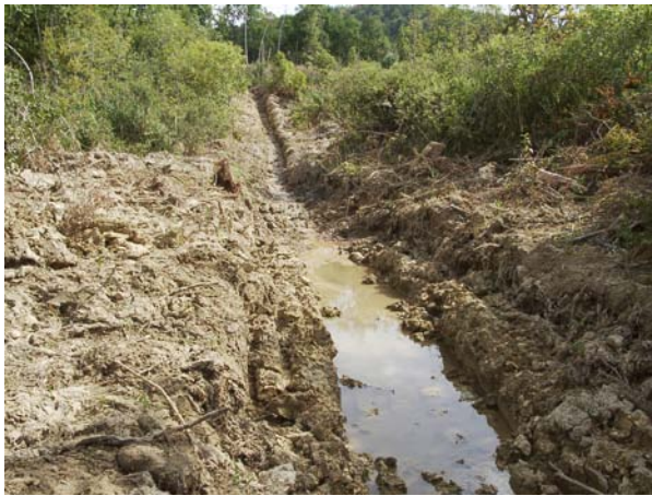
Photographie 12. Recalibrage d'un cours d'eau de têtes de bassin en Bourgogne.
