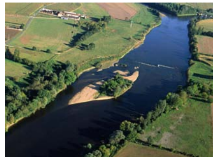
Photographie 5. Sur la Vienne, barrage de Maisons Rouges détruit.
