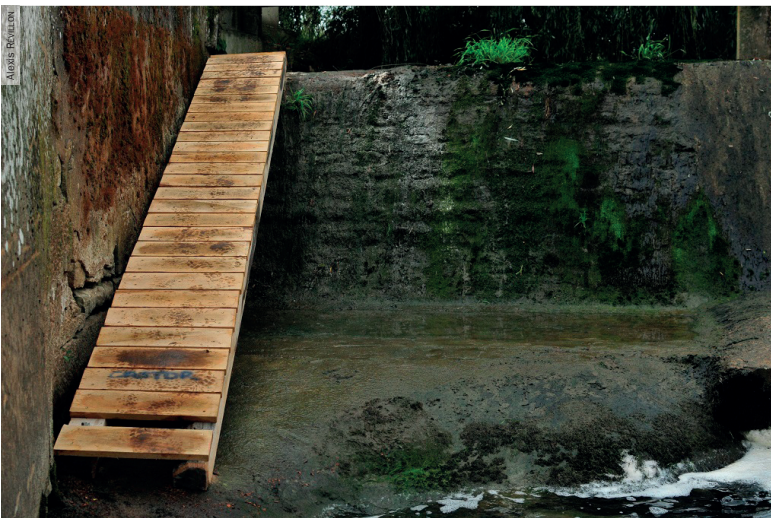
Photographie 4. Rampe à castor, La Chapelle de Bragny, septembre 2014.
