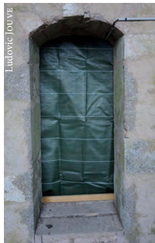
Bâche à l'entrée du grenier de l'église pour l'isoler de la lumière et des courants d'air
